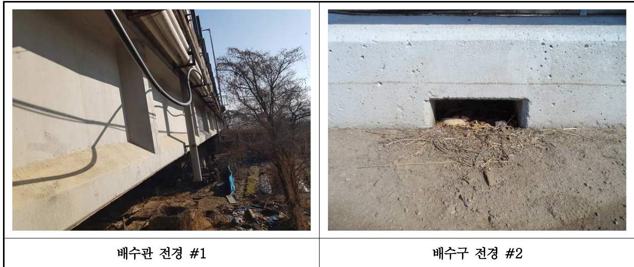
【사진 3.25】 배수시설 전경
