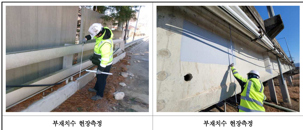
【사진 2.1】 부재 현장측정 전경
