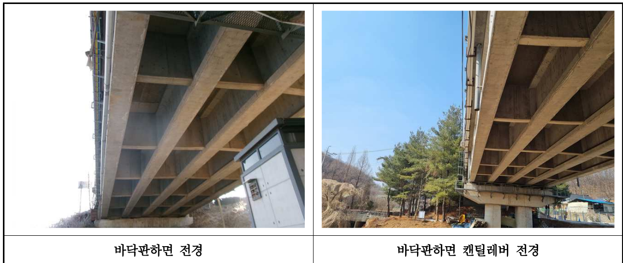
【사진 3.4】 바닥판하면 전경
