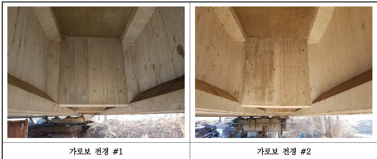
【사진 3.8】 가로보 전경
