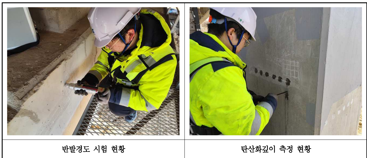
【사진 3.34】 콘크리트 내구성조사 현황
