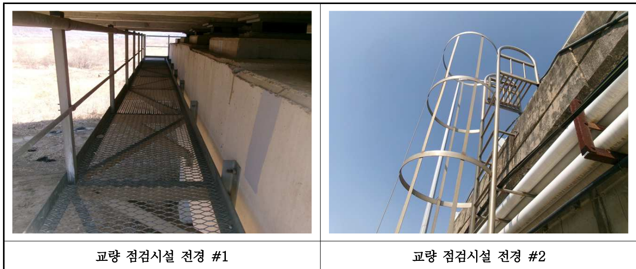
【사진 3.29】 교량 점검시설 전경
