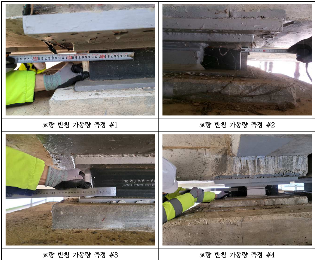
【사진 3.19】 교량받침 이동량 측정
