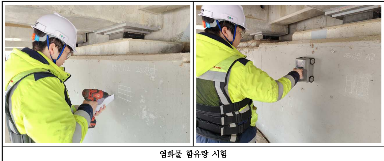
【사진 3.38】 염화물 함유량 시험 현장사진
