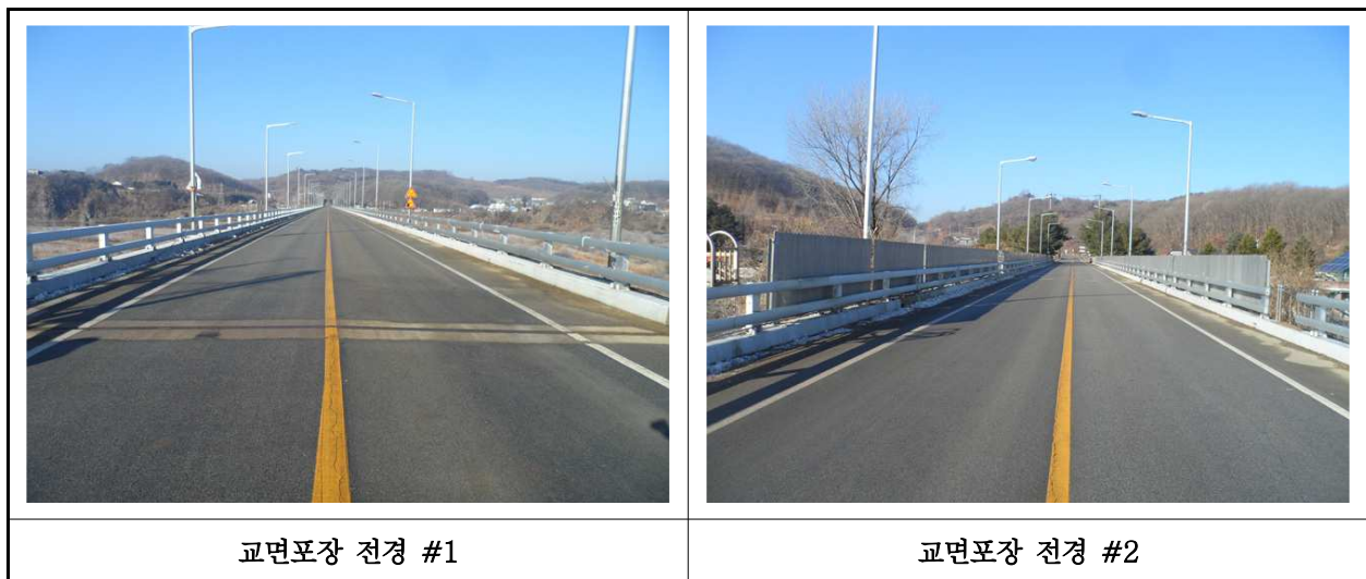
【사진 3.23】 교면포장 전경
