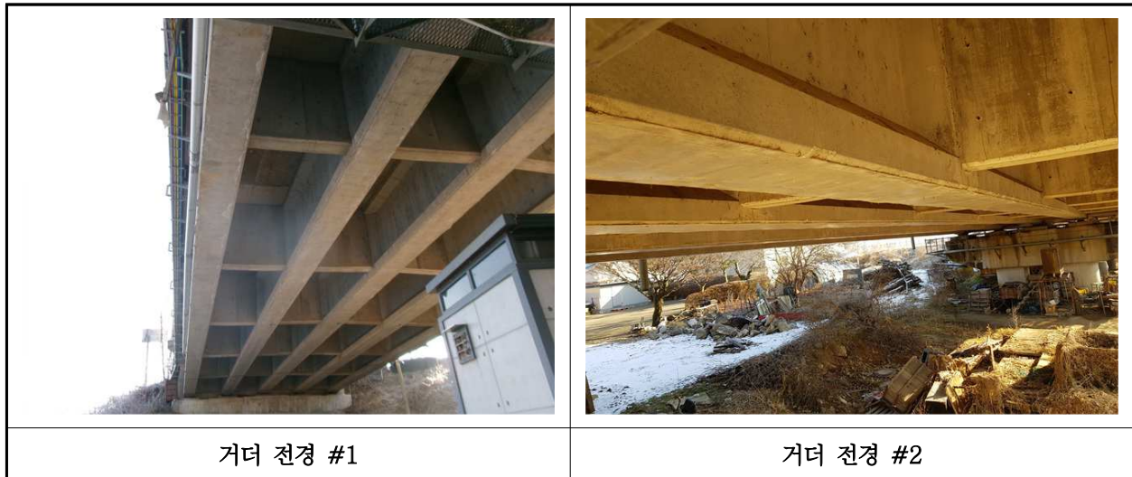
【사진 3.6】 거더 전경
