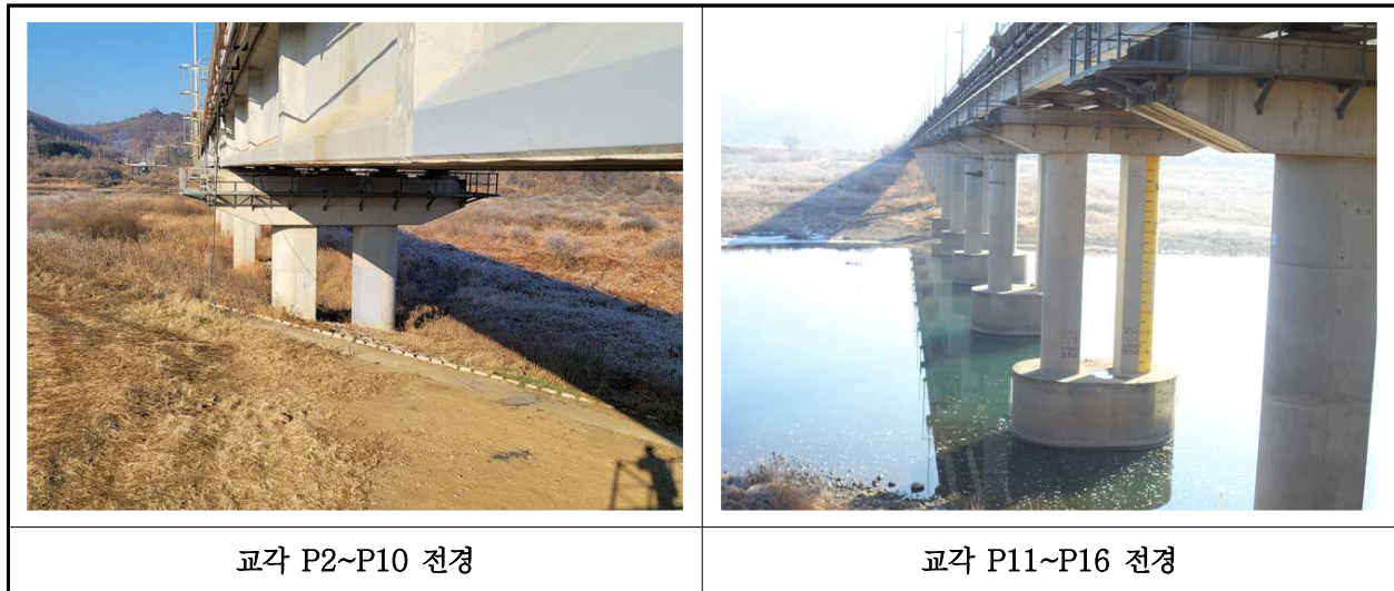
【사진 3.12】 교각 전경
