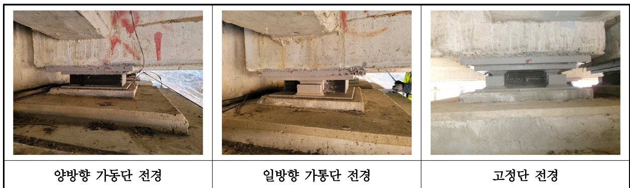
【사진 3.16】 교량받침 전경
