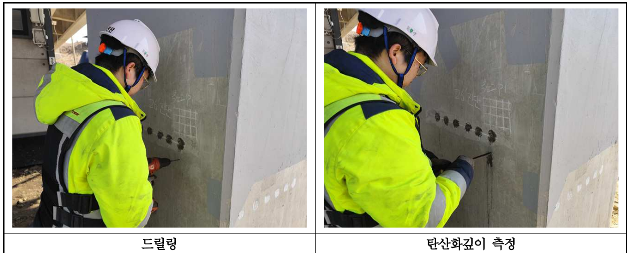
【사진 3.37】 탄산화 깊이 측정 현장사진
