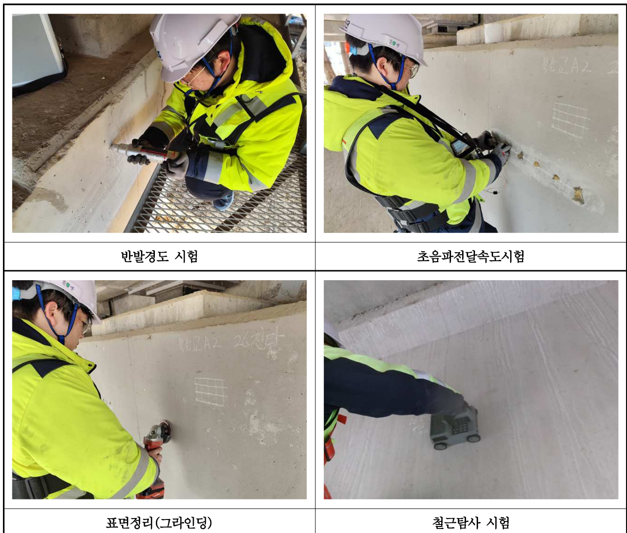
【사진 3.35】 콘크리트강도 시험 현장사진
