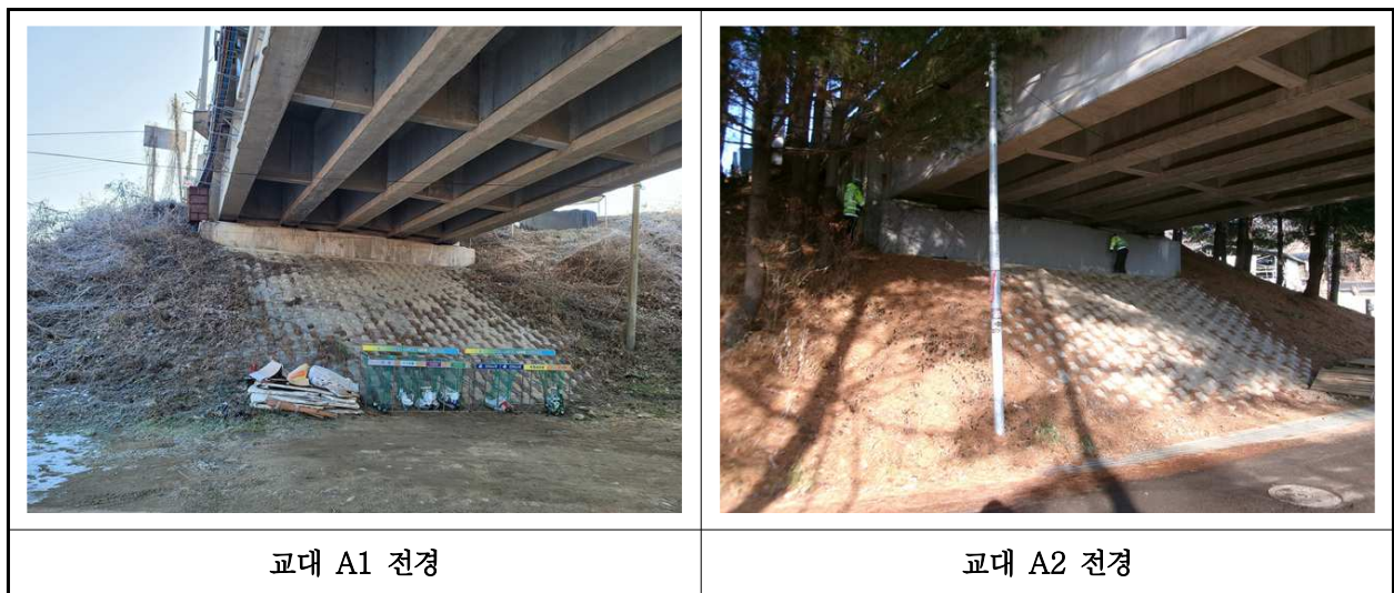
【사진 3.10】 교대 전경
