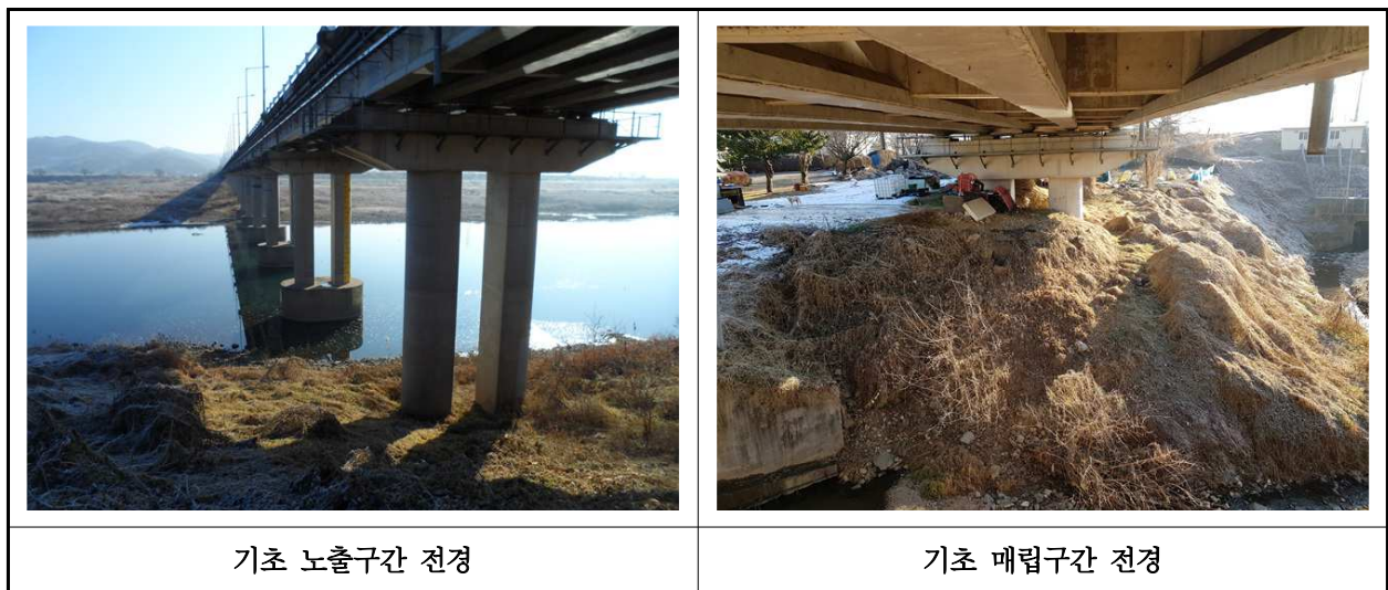
【사진 3.14】 기초 전경
